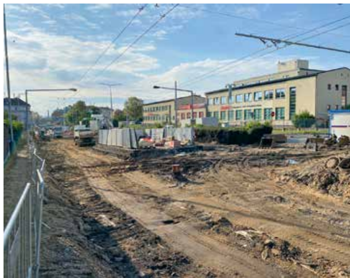
PROSECKÁ V PRŮBĚHU OPRAVY v úseku ulic Františka Kadlece-Na Labuťce.
