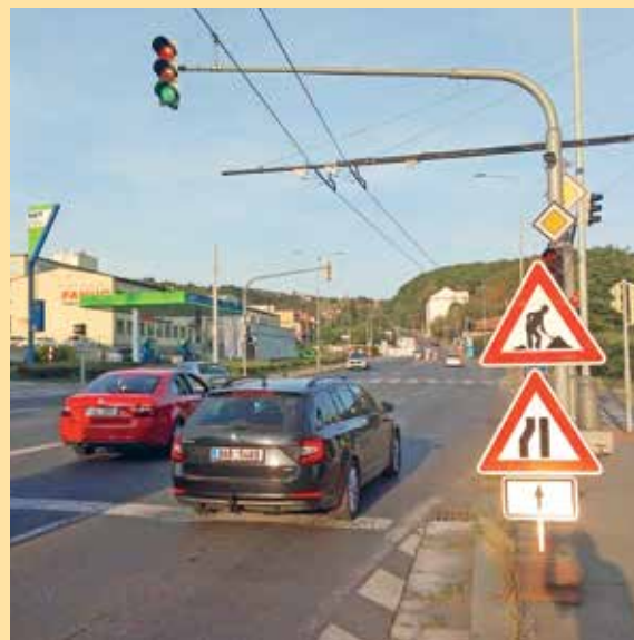
ÚSEK DLOUHÝ 200 METRŮ se bude opravovat dva měsíce.
