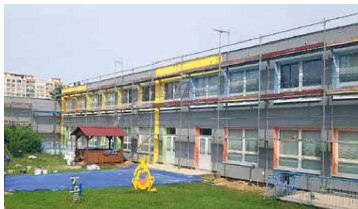
REKONSTRUKCE JIŽNÍ FASÁDY MŠ Poznaňská byla v polovině srpna v plném proudu. Ozdobí ji i venkovní žaluzie. Vše se stihne do začátku školního roku.
