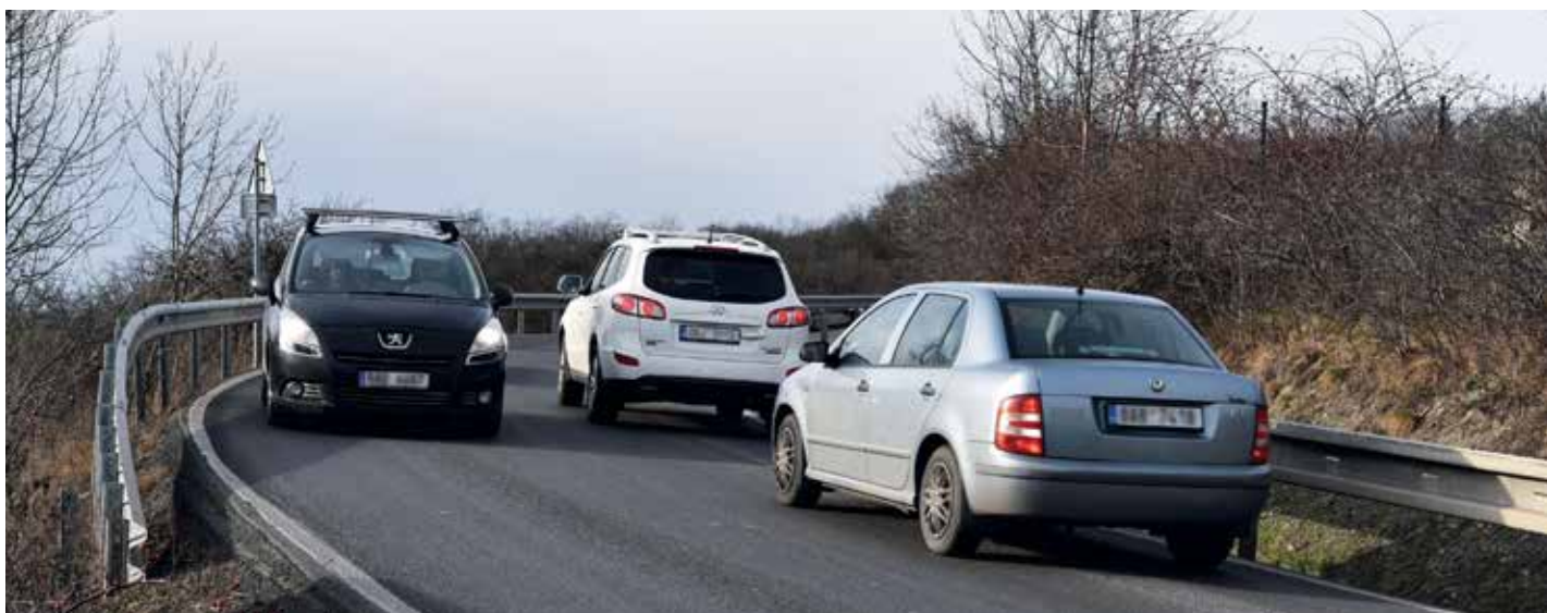
SILNICE mezi Bohnicemi a Trojou slouží jako alternativní spojení občanů severní části Prahy 8 s městem.
