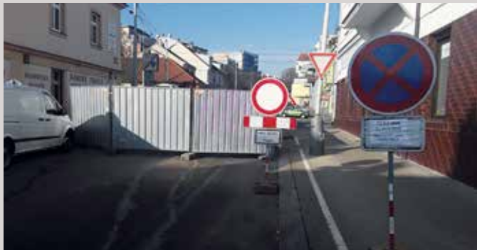
OPRAVA KANALIZACE uzavřela ulici Ke Stírce.
