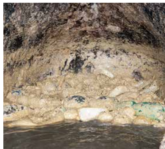
TUKOVÉ NÁNOSY v pražské kanalizaci se často odstraňují ručně.
