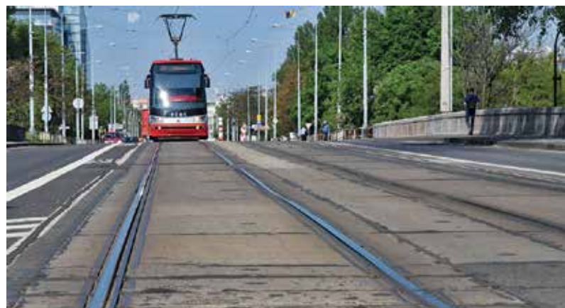
TRAMVAJE na mostě kvůli jeho dezolátnímu stavu jezdí krokem.
