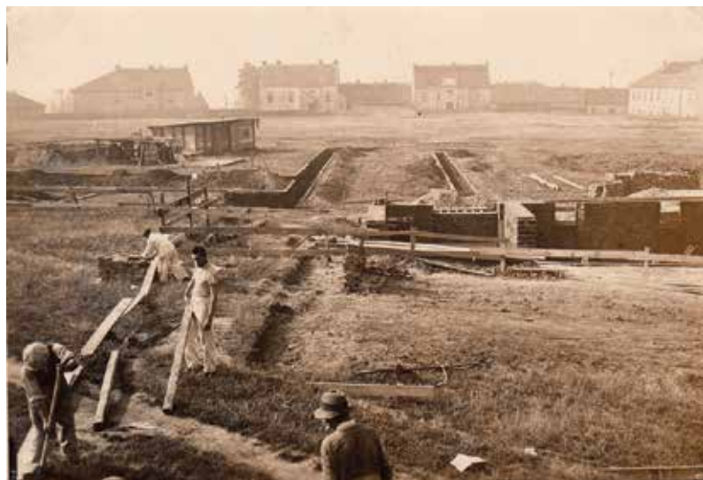
VÝSTAVBA SALESIÁNSKÉHO CENTRA v Kobylisích. Foto: archiv pamětníka
