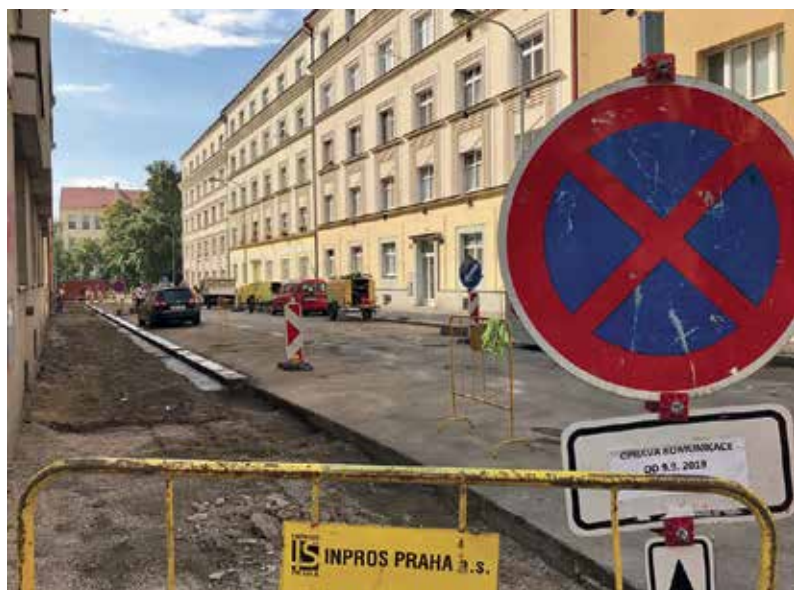
PRŮBĚH OPRAVY chodníku v ulici Andrštova. Foto: MČ Praha 8
