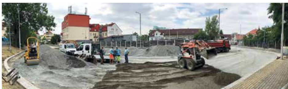
PRŮBĚH PRACÍ při opravě autobusového terminálu v červenci. Foto: Praha 8
