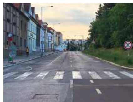
PŘECHOD PRO CHODCE před a po realizaci.
