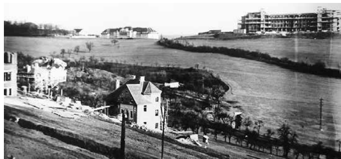
POHLED NA STAVBU pavilonu Nemocnice Na Bulovce (1925–1931), v popředí dnes již přestavěná vila č. p. 1343. Foto: archiv MČ P8
