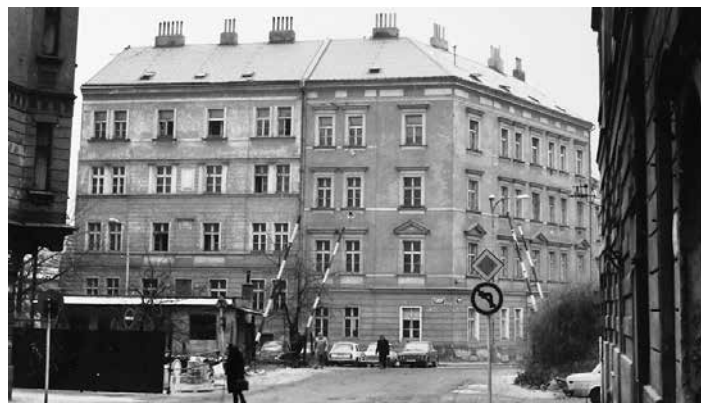
POHLED NA DOMY č. p. 479/19 a rohový dům č. p. 404/1 v ulicích Na Žertvách a Ronkově, oba zbořeny v roce 1986. Foto: archiv MČ P8
