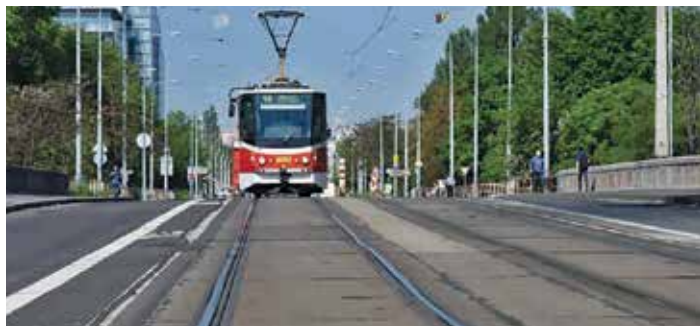
VIDITELNÉ POŠKOZENÉ kolejové pásy na mostě. Foto: Vladimír Slabý
