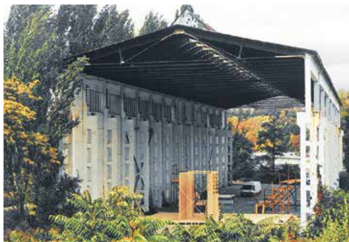
4. ŘÍJNA 2008 – montážní hala se zbytky filmařských rekvizit.
