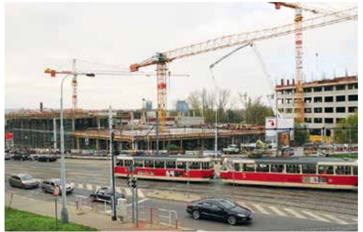
DOKONČENÍ VÝSTAVBY Nové Palmovky se opět pozdrží.
