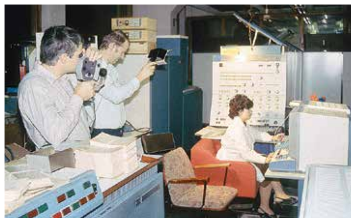
ROK 1985 – instalace terminálového systému TC.
