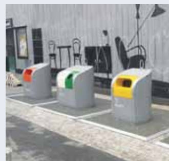
PRVNÍ PODZEMNÍ kontejnery v Praze 8 byly vybudovány v Karlíně.
