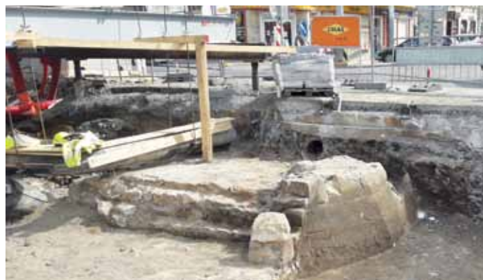
PÍSKOVCOVÉ PÍLÍŘE mostu přes Rokytku z konce 19. století, které odhalila právě probíhající rekonstrukce.
