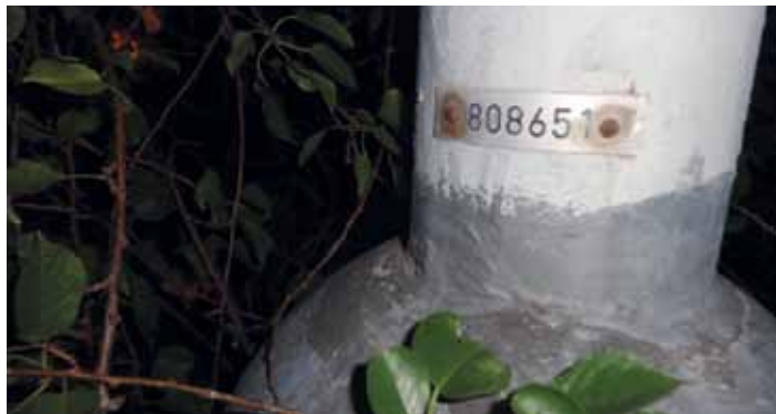
UMÍSTĚNÍ ŠESTIMÍSTNÉHO identifikačního čísla na lampě veřejného osvětlení. Foto: Daniel Sklenář
