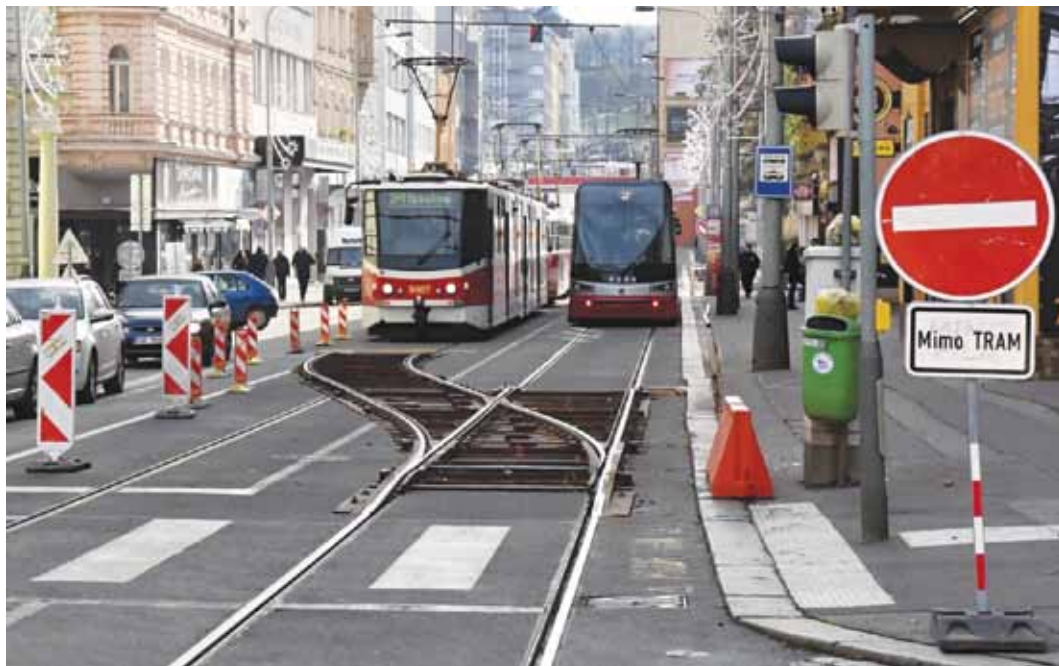
ZENKLOVU ULICI ČEKÁ KOMPLETNÍ REKONSTRUKCE. Odstartovala na začátku listopadu, kdy byla zahájena oprava mostu přes Rokytku, takže průjezd Elsnicovým náměstím je značně omezen. Foto: Vladimír Slabý
