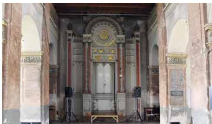
SOUČASNÝ VZHLED interiéru Nové libeňské synagogy. Foto: Vladimír Slabý
