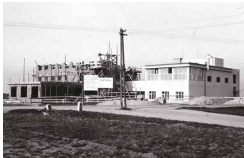
STAVBA SALESIÁNSKÉHO centra v roce 1937.
