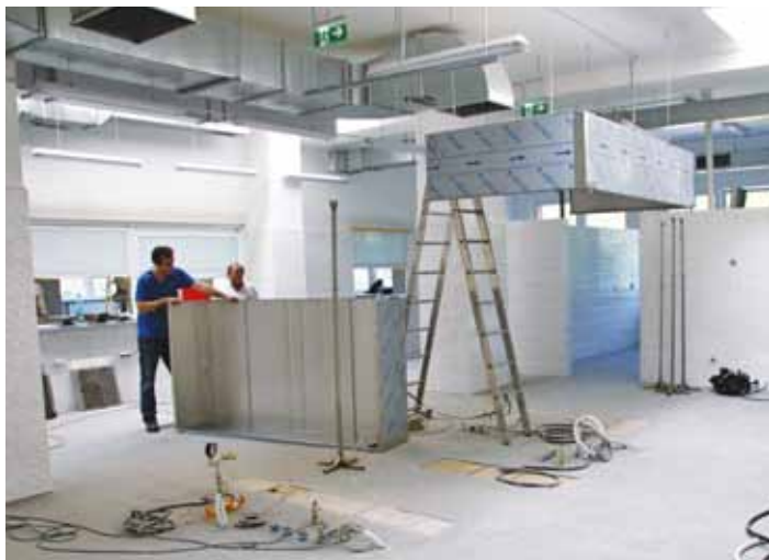
ZŠ DOLÁKOVA , průběh rekonstrukce kuchyně.
