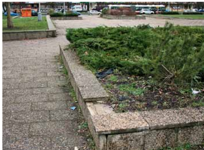
▲ Prostor mezi OC a KD Krakov. Plochu tvoří zpevněná část, tzv. „náměstí“, a sousední travnatá část. Prostor byl kolaudován v roce 1989 a v současnosti je již velmi zchátralý.
