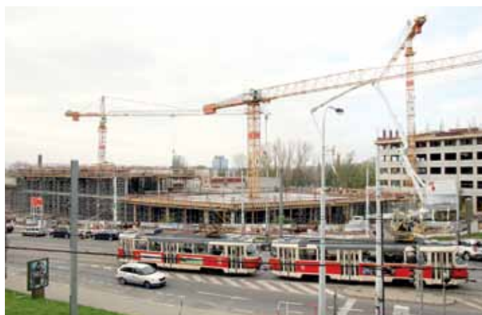
▲ Práce na výstavbě pokračují rychle i díky příznivému počasí
