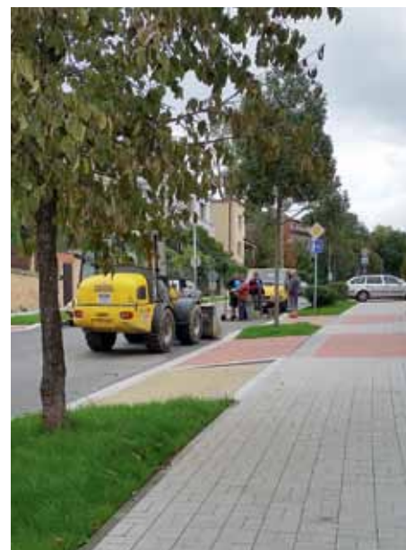
▲ Dokončovací práce v ulici Na Stráži
