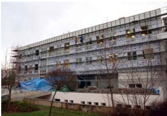
Rekonstrukce se uskutečnila loni na podzim
