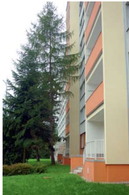
Vzrostlý modřín začal ohrožovat dům v Červenkové ulici
