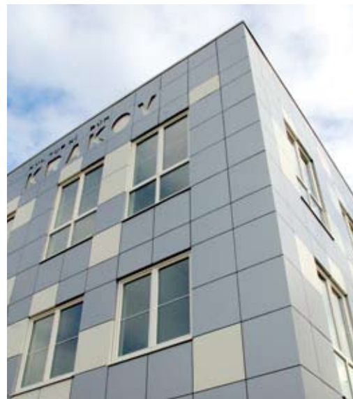
Nová fasáda ušetří náklady na vytápění
