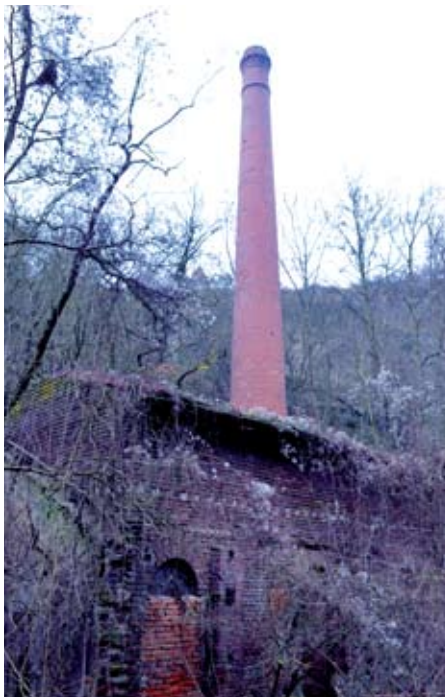
Objekt bývalé fabriky v současnosti chátrá
